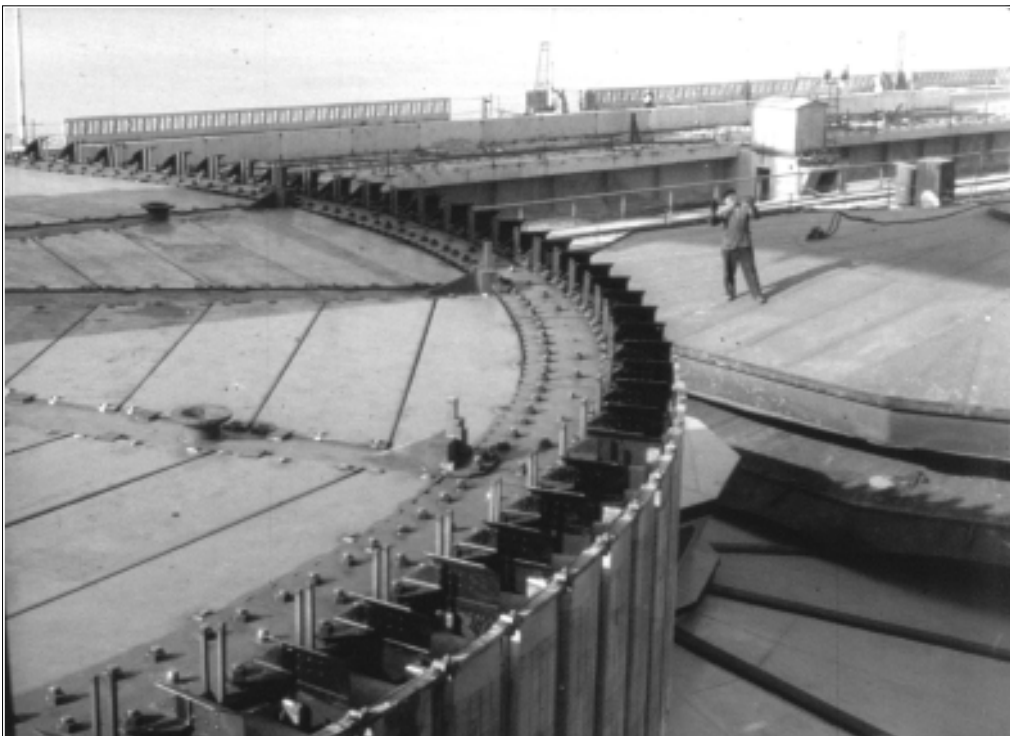
Панорама будівництва Дніпродзержинської ГЕС. 1965 р. Од. об. 3642.
