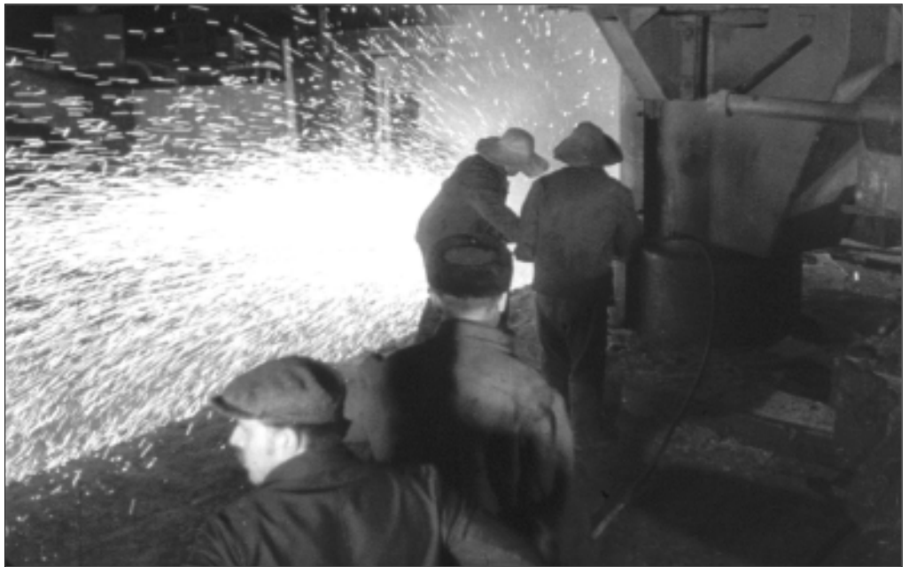
Найпотужніша у світі домна на Криворізькому металургійному заводі. Дніпропетровська область, 1960 р. Од. об. 2138.
