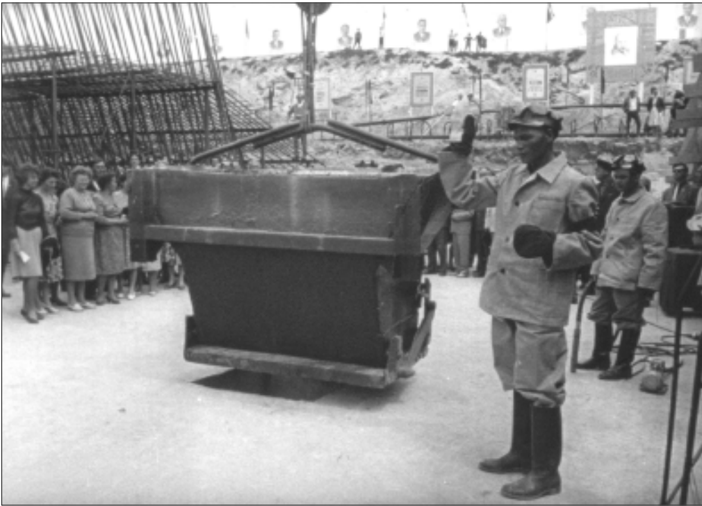
Закладка першого кубометра бетону в будівництво Київської ГЕС. 1964 р. Од. об. 5232.
