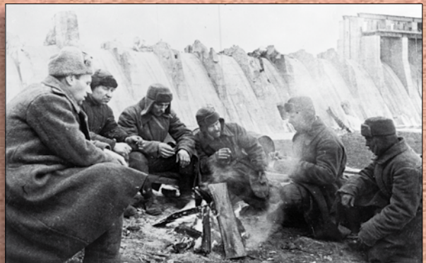
Воїни біля зруйнованої греблі Дніпрогесу імені В. І. Леніна. Запоріжжя, жовтень 1943 р. ЦДКФФА України ім. Г. С. Пищичного, од. обл. 2-118717
