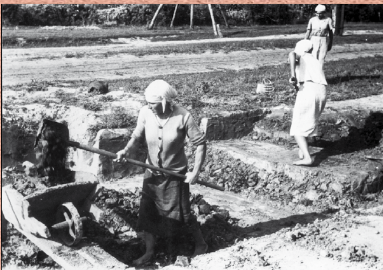
Жінки на будівництві дороги Київ - Бориспіль. Київська обл., серпень 1943 р. ЦДКФФА України ім. Г. С. Пшеничного, од. обл. П-8376
